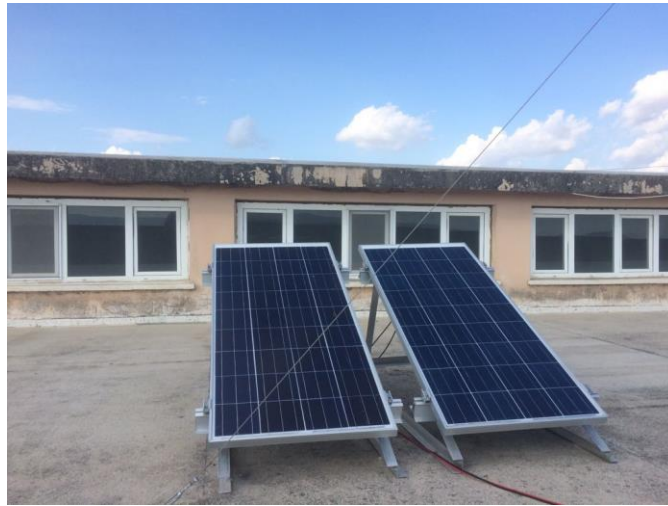
Şekil 8. Kullanılan PV-kollektörleri (2 adet 150 Watt güçte )
